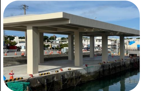
★奥武漁港 防暑施設(完成)
