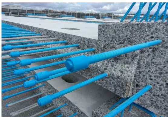
★沖縄自動車道 許田高架橋(床版取替)
