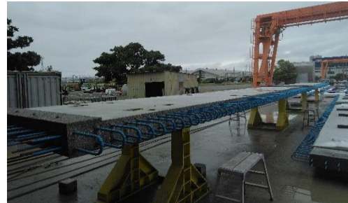
★胆沢川橋 床版取替
