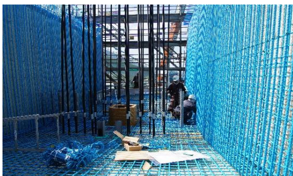
★西海岸道路高架橋
