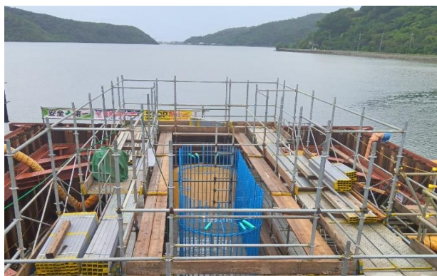
★県道9号線 大保大橋(下部工)
